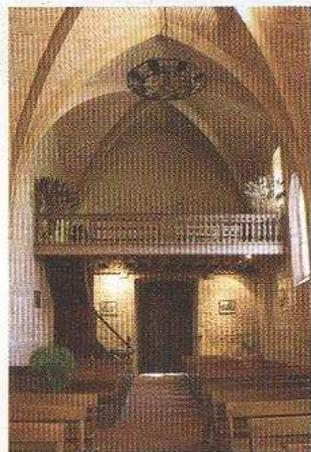
Voûtée d'ogives en briques, avec trois travées rectangulaires, deux de dimensions égales et une travée de chœur plus étroite. Les murs de cette nef (rehaussés au XV<sup>e</sup> siècle ?) sont réalisés uniformément en appareil de blocage (galets ou pierres disposés sans ordre
